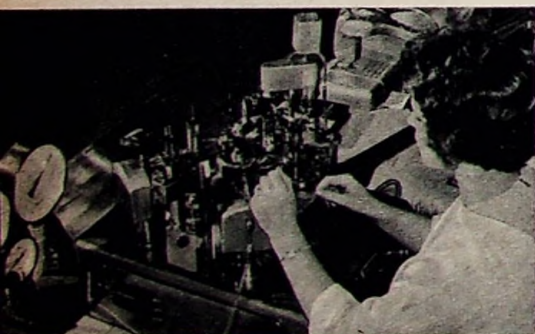
Bild 7 (oben). Einschmelzkarussell zum Verschmelzen des Glasfußes mit dem Glaskolben
